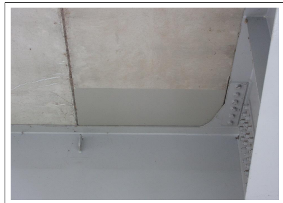
S11 바닥판하면 보수부 상태양호
