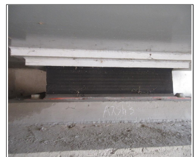
받침장치 A2-Sh3 전경
