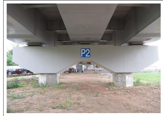
P2 코핑 보수부 상태양호
