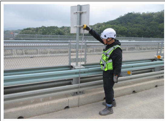
중앙분리대 높이 측정(h=1.6m)
