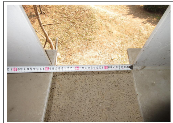
거더 하부 유간측정 전경
