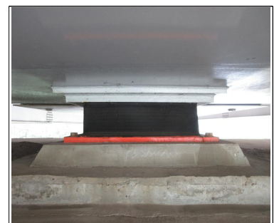
받침장치 P5-Sh2(A2) 전경
