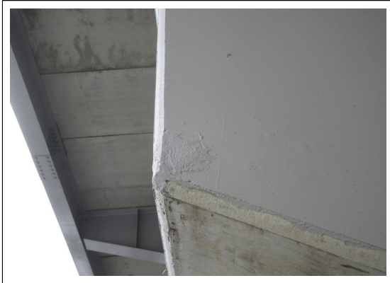
P1 코핑 파손 보수부 상태양호
