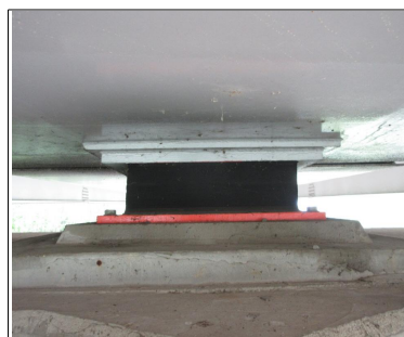
받침장치 P9-Sh2(A2) 전경
