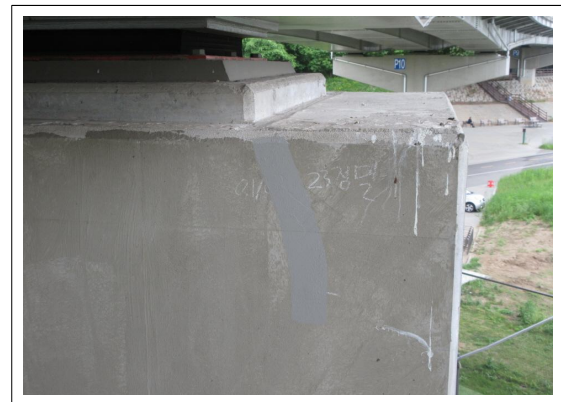
P11 코핑 보수부 상태양호
