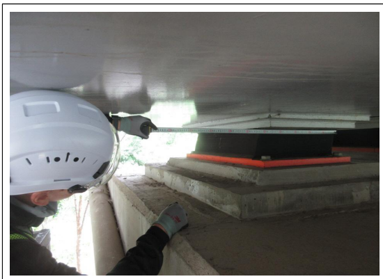
받침 이동량 측정 전경 ①
