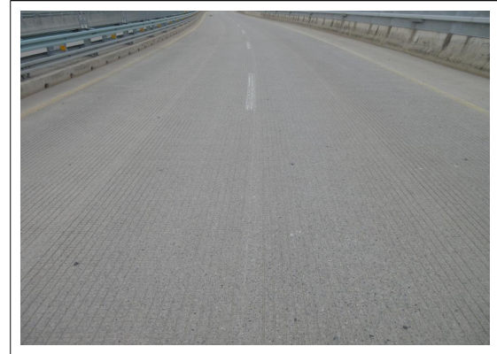
S13 교면포장 상태양호
