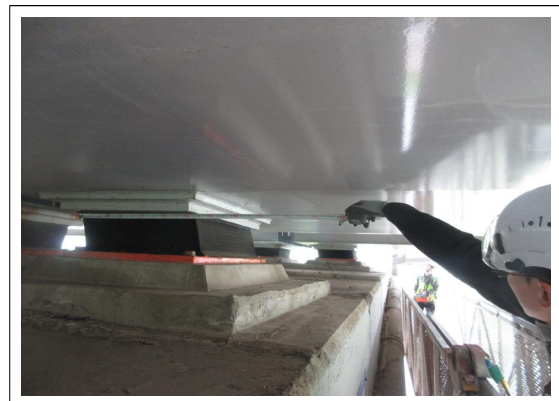
받침 이동량 측정 전경 ②
