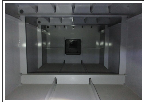
S1-G1 거더내부 상태양호
