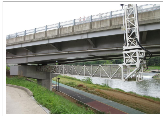
b. 점검차를 이용한 근접 외관조사
