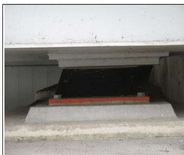
받침장치 A1-Sh1 전경
