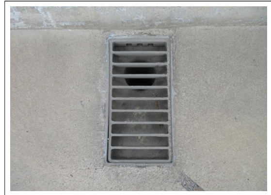
S14 배수구 상태양호
