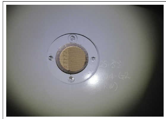
S14-G2 거더내부 환기구 볼트 상태양호
