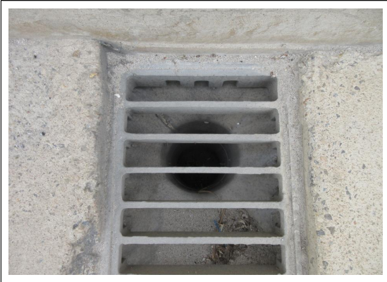
S9 배수구 상태양호
