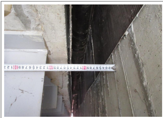
거더 상부 유간측정 전경
