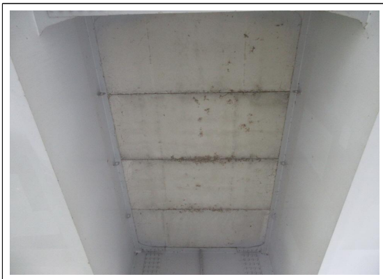
S10 바닥판하면 상태양호
